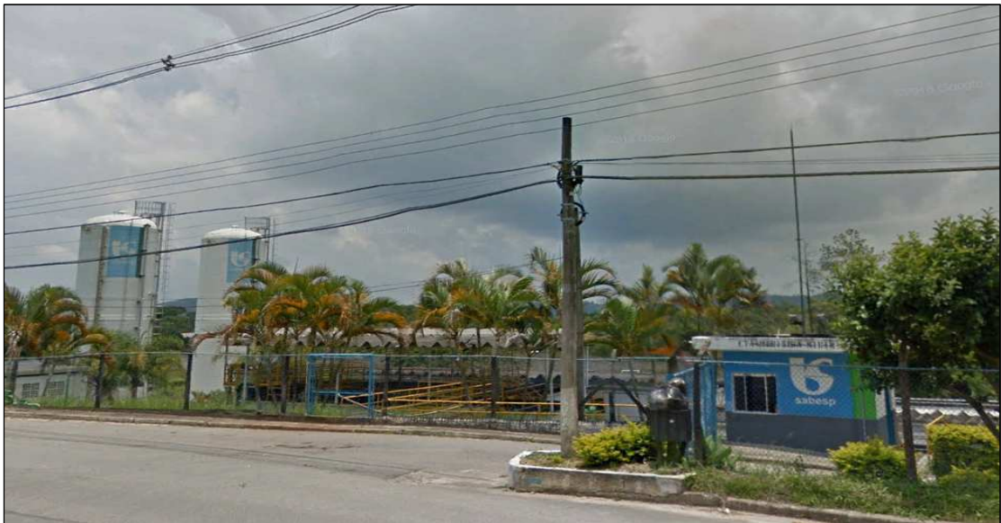
Figura 7 - Entrada da ETA Biritiba Mirim a partir da Rodovia Mogi-Salesópolis
