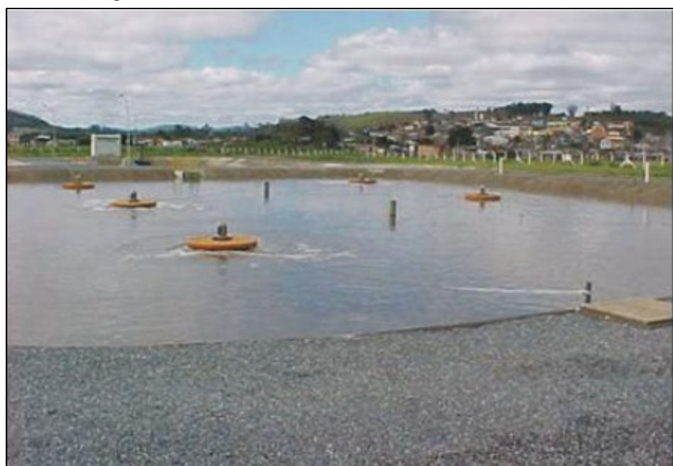
Figura 12 - Vista Parcial da ETE Biritiba Mirim
